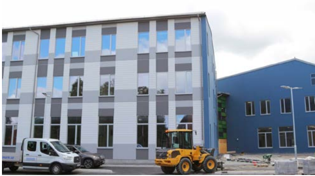
Bild 6. Nya Sylteskolan under byggnation.
