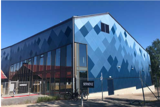
Bild 7. Nya idrottshallen på Sylteskolan.
